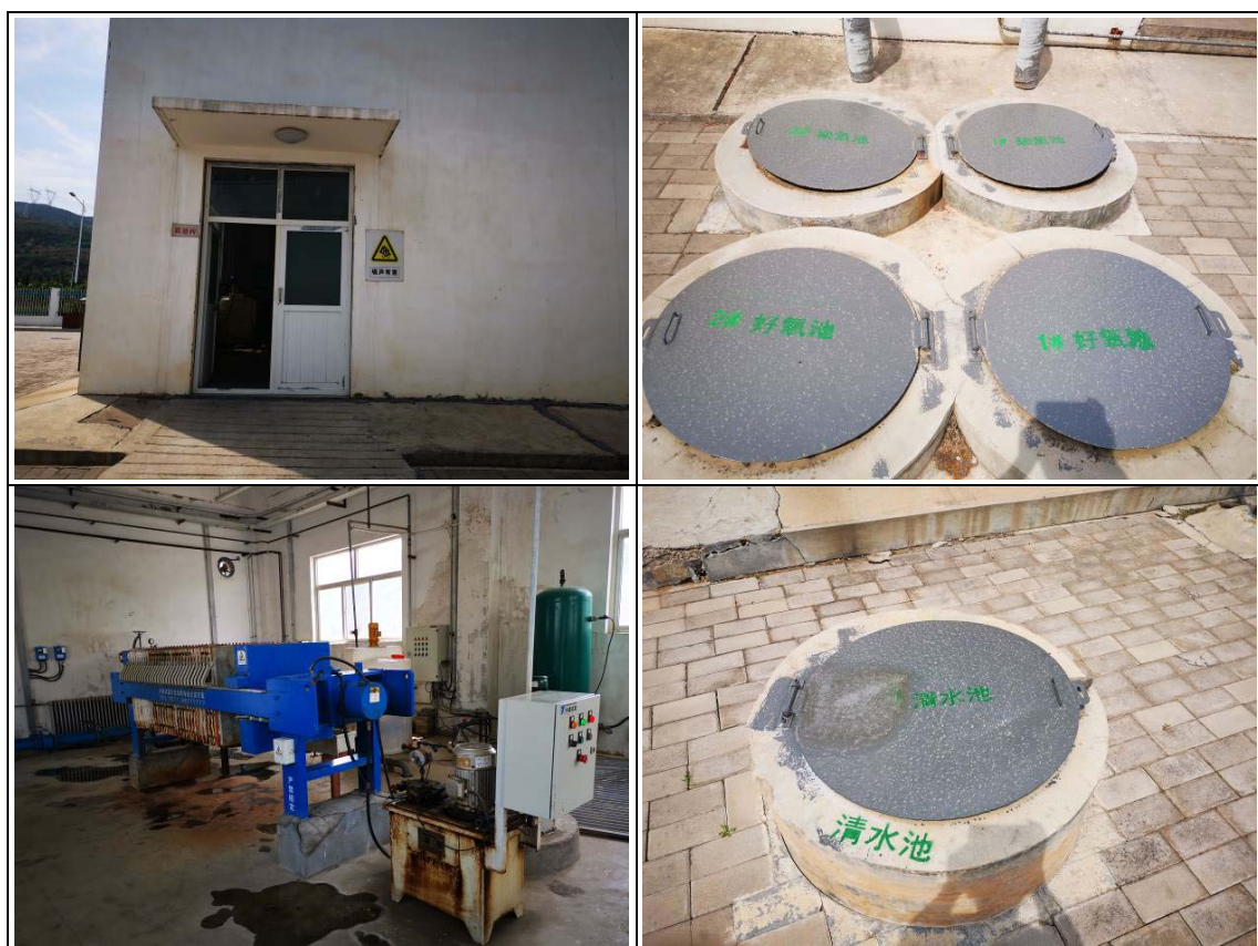
图 6-3-6 生活污水处理站实景图
