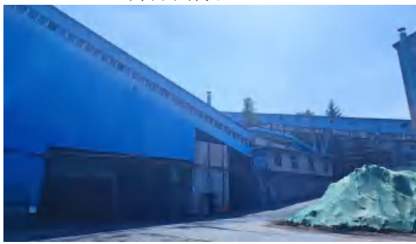
封闭式皮带走廊
