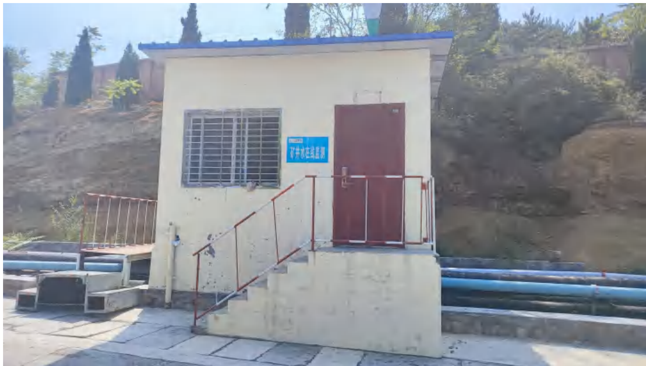
矿井水在线监测室
